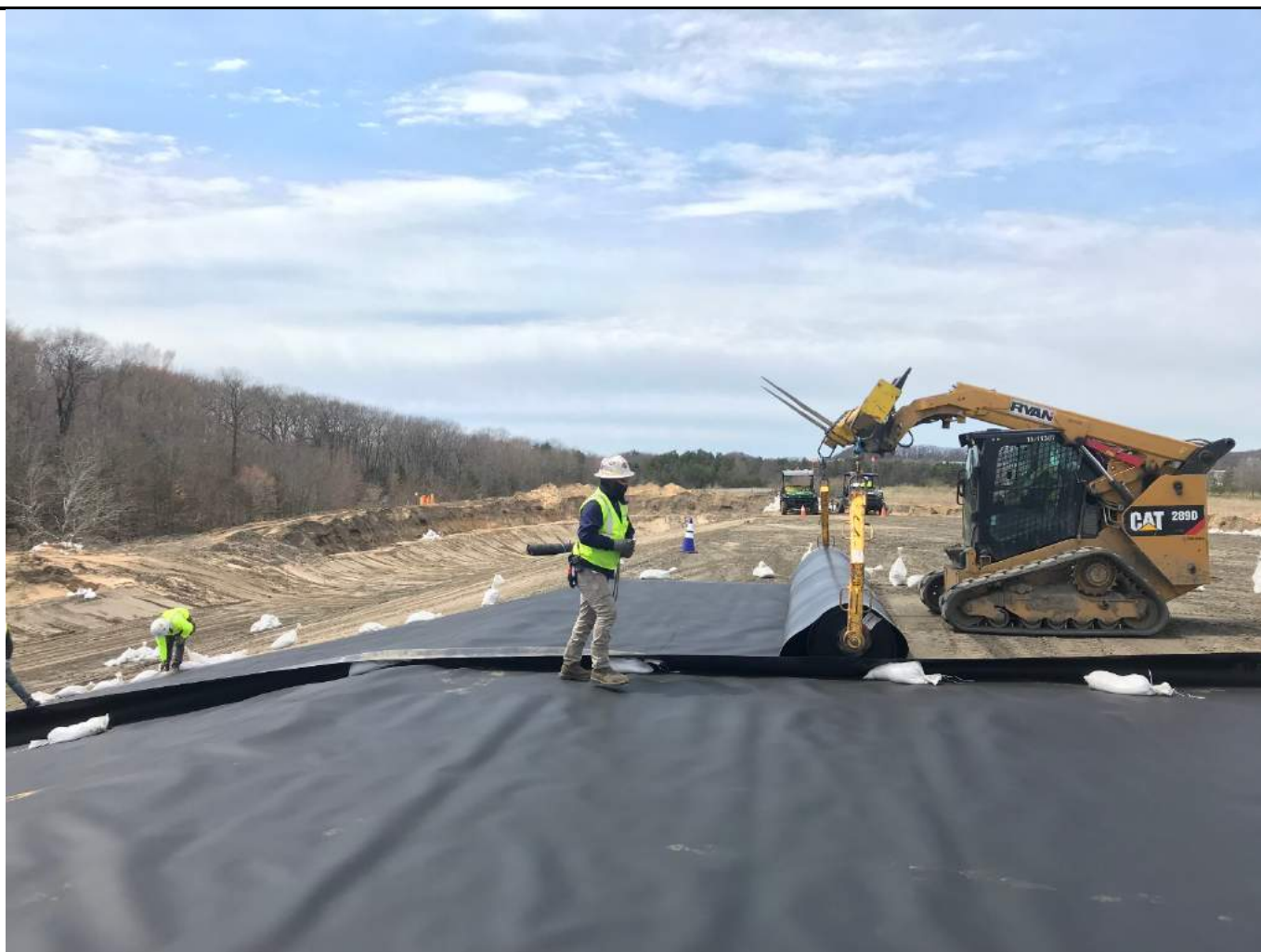
Deploying geomembrane.
