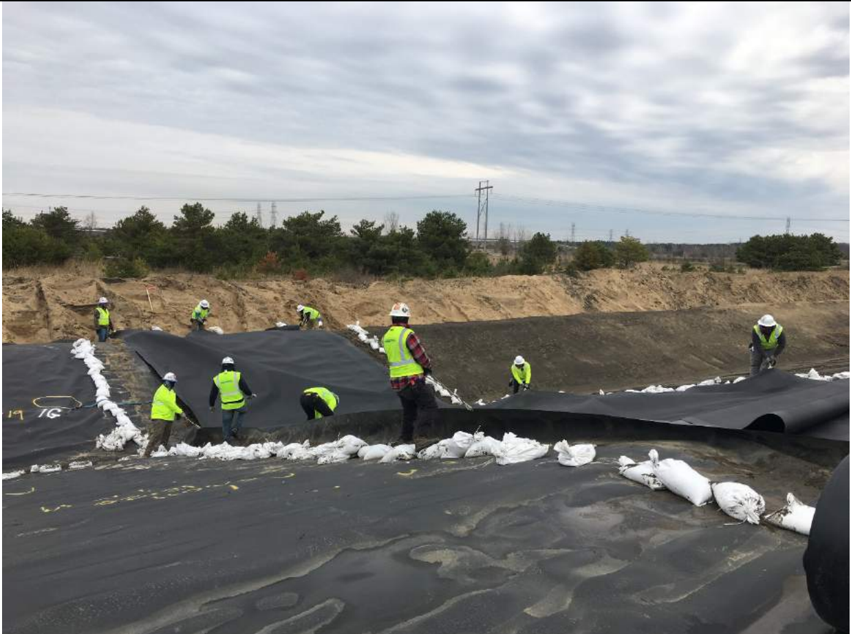
Deploying geomembrane.
