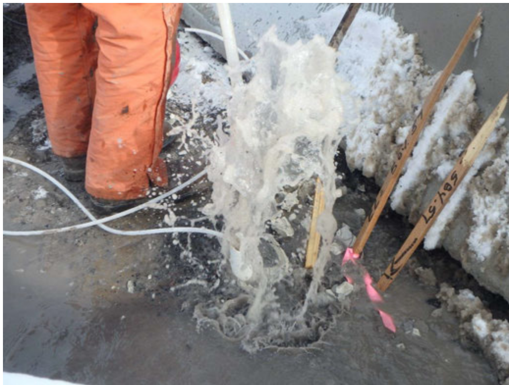
Flushing MW-15006
